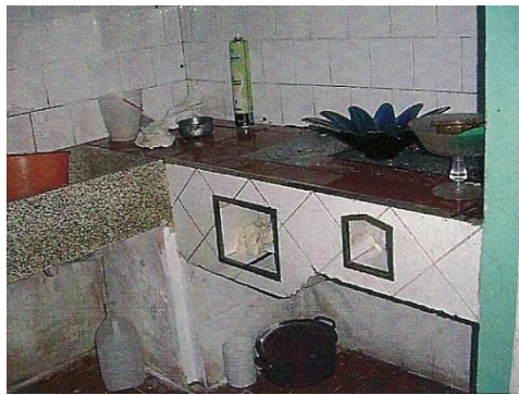
Cocina económica de dos fuegos en una casa del Ravall Vell 9
