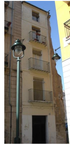
Casa de dos claus en carrer Barbacana 3
