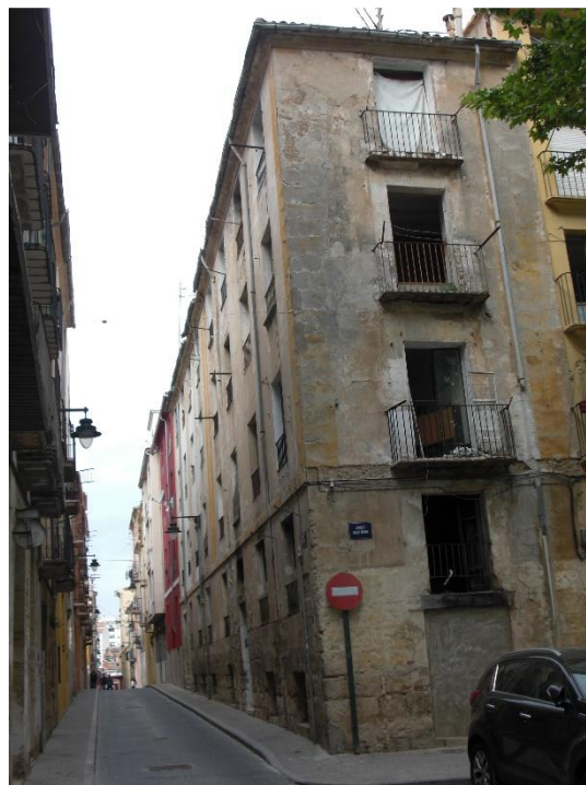
Primera casa para obreros en Alcoy, esquina de las calles La Sardina-Sant Mateu
